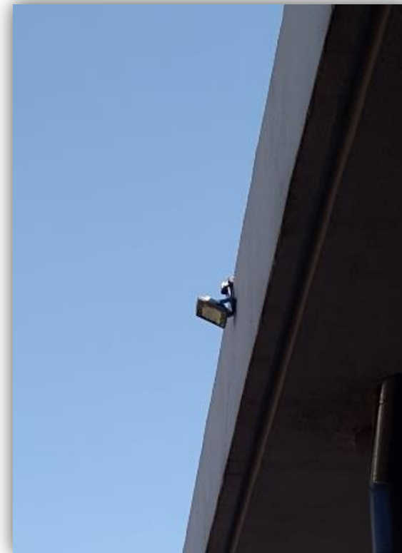
Instalación de reflectores para mejor iluminación..
