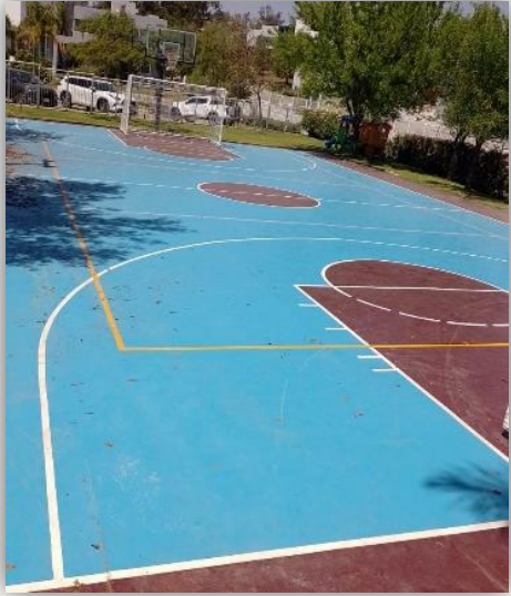
Mantenimiento a la pintura de la cancha de usos múltiples.
