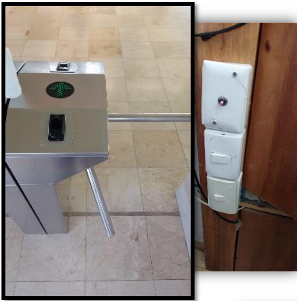
Instalación de botoneras para ingreso manual
