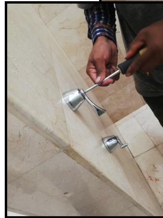
Instalación de pasamanos y soportes en baños, así como reparación de llaves
