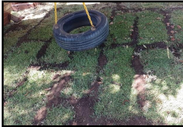
Instalación de pasto en área de juegos
